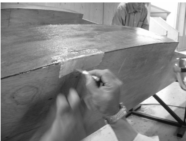
図9 外板合わせ部のFRP補強
