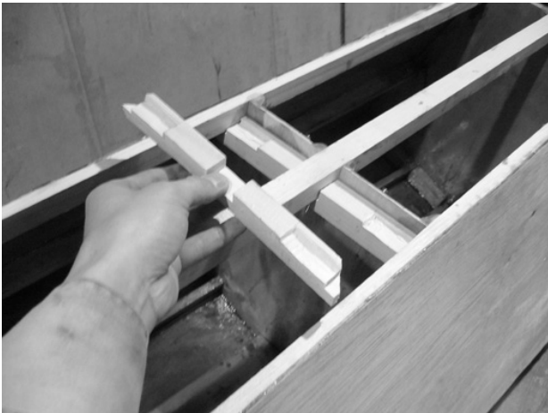
図 5 フロート支持部の内部補強
