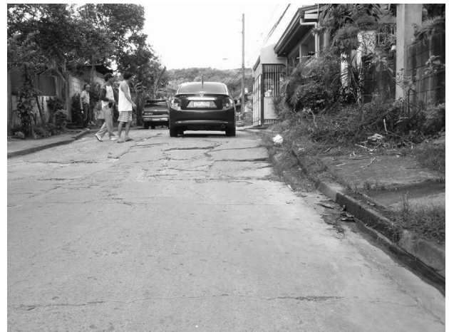
写真2 新設測線地点 (JUA-A)
