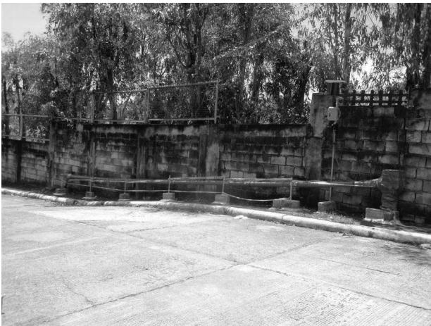
写真3 観測システムの全景
